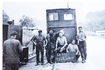
Devant la mairie de Roberval, pendant les travaux du viaduc: «la mort du petit train» (photo: Jocelyne Grava). locomoteur 0C0 Gmeinder.
